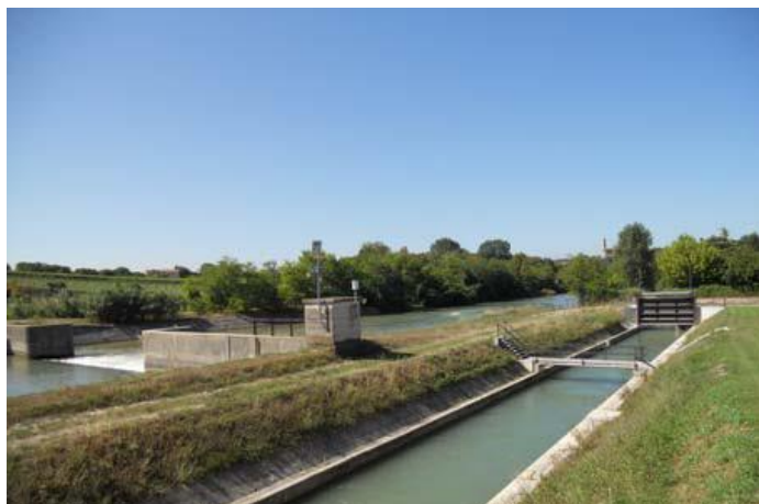
Canale di scarico
